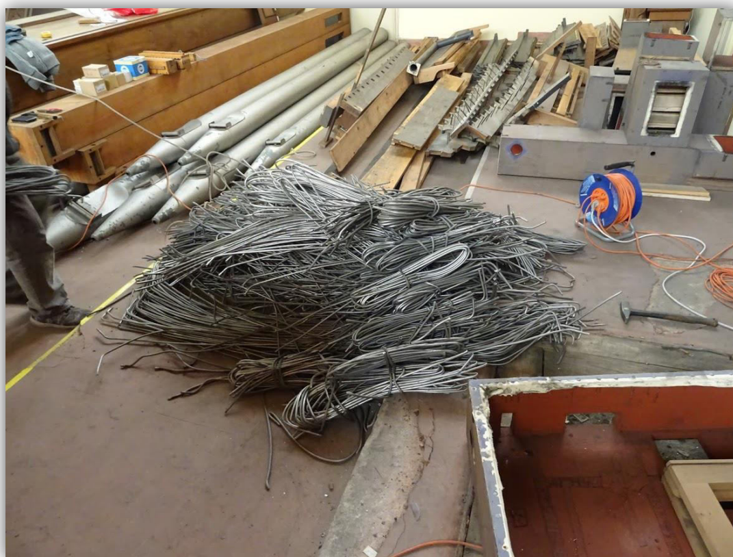
Obr. 29: Vyjmuté pneumatické vedení a další komponenty
